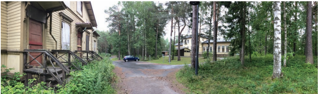
Kuva 37. Näkymä Tuiranpuiston keskiosan tyhjillään olevien rakennusten edustalta, taustalla entinen sairasosasto, nykyinen päiväkot.
